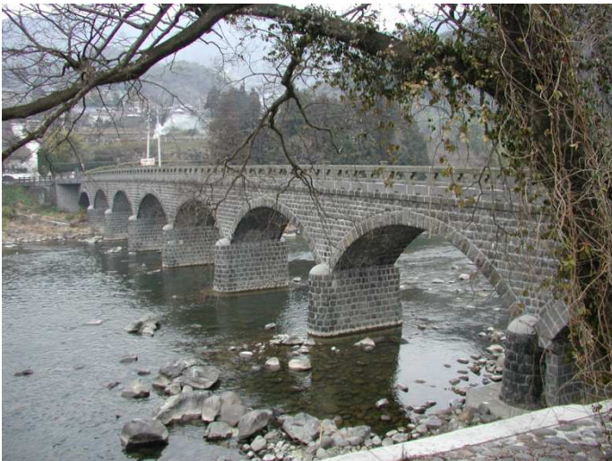
← 耶馬溪橋（オランダ橋）日本最長の石橋 橋長： 116.0m 橋幅：4.1m 径間：12.8m 拱矢：3.0m 8連アーチ 架設：大正12年 大分県指定有形文化 財
