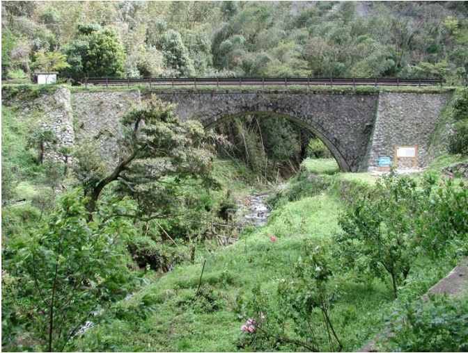
山口県で最大の石橋 三見橋 径間：54尺（16.4m） 橋長：21.4m 橋幅：3.4m 水面高さ：13.5m 迫石・輪石 32個 竣工：大正3年2月
