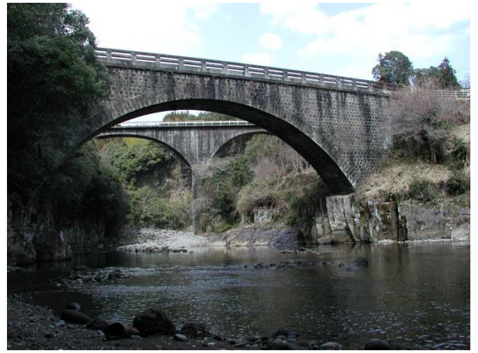
↑ 日本最大径間の石橋 轟（とどろ）橋（上写真 奥側）豊後大野市清川町左右知地区 日本1位の径 間 奥岳川 橋長：68.5m 径間：左：32.18m 右： 26.5m 架設：昭和9年(1934) 形式：2連石造アー チ 2位 出合橋（上写真手前）豊後大野市清 川町左右知 日本2位の径間 形式：1連石造アー チ 橋長：32.3m 径間：29.3m 完成：大正14年 (1925)
