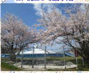
(3) 桃山3号配水池
